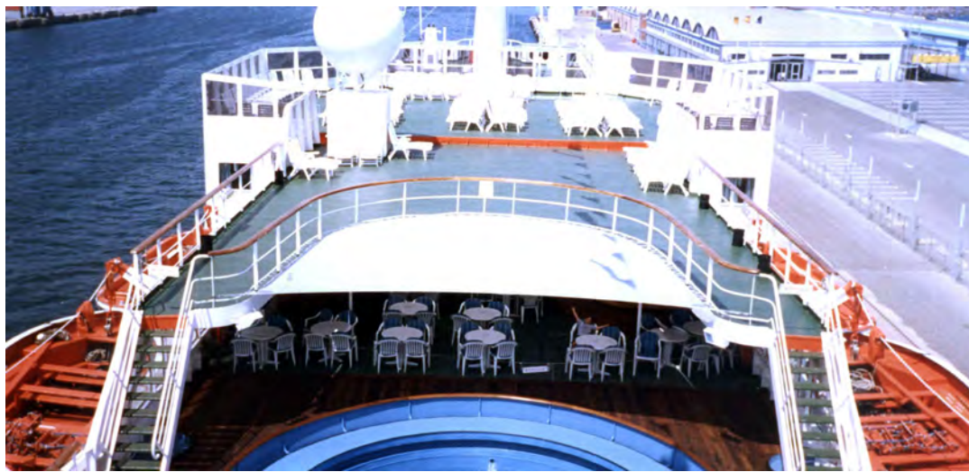
Producción y montaje de toldillas y carpa tensostática para la cubierta del buque Don Juan.
