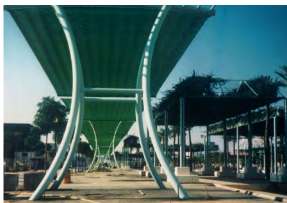
Cubierta para la Avenida 3 de la EXPO'92. Sevilla
