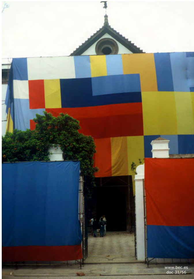
Cubierta de la fachada del Convento de Los Remedios.
