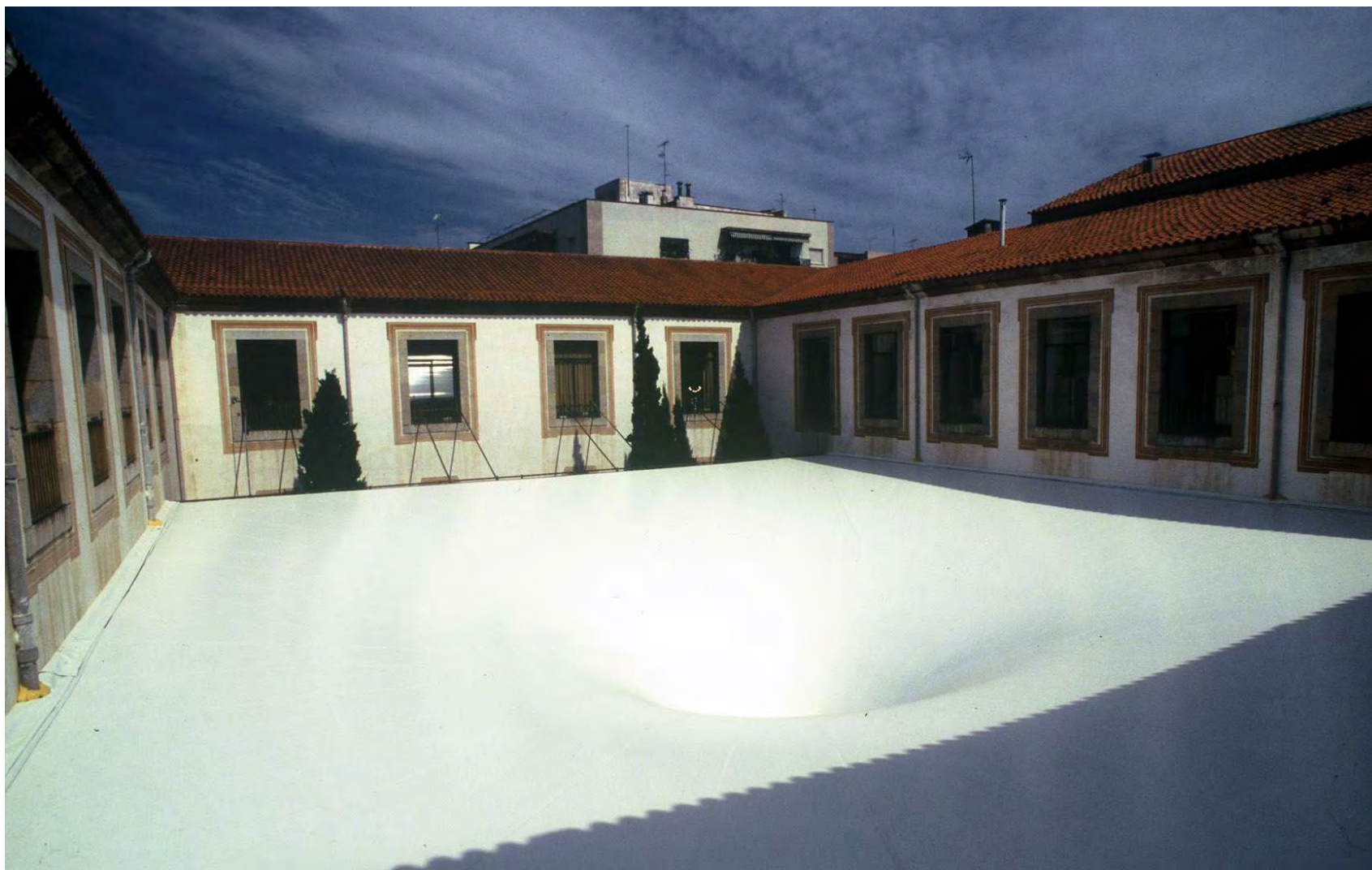
Cubierta textil en forma de embudo del Patio de la Casa de la Cultura "Bisbe Lorenzana" de Girona
