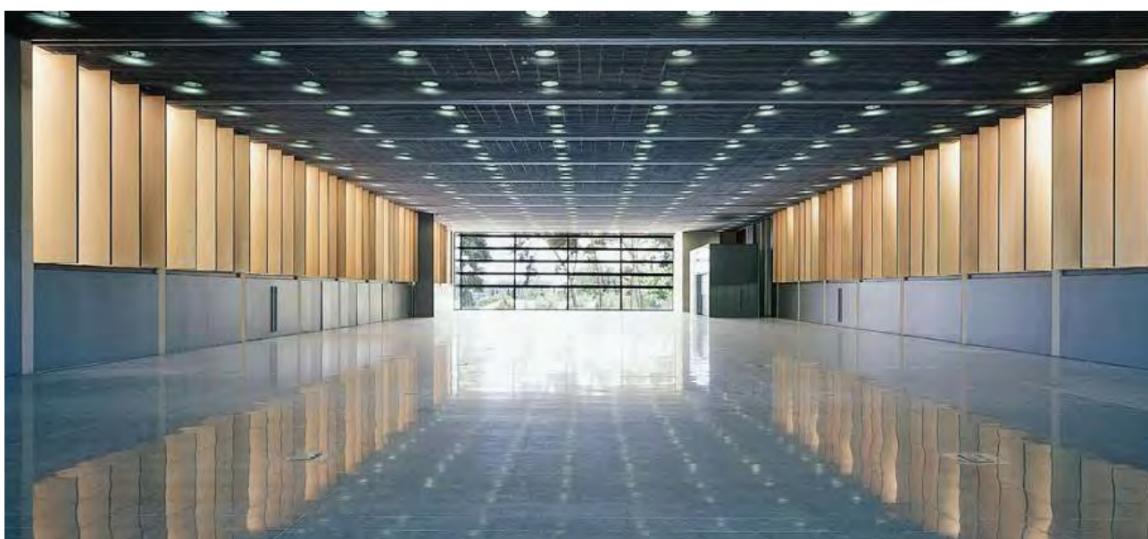
Producción y montaje de techo técnico de malla de acero galvanizado y telón de grandes dimensiones para el Palacio de Congresos de Cataluña.
