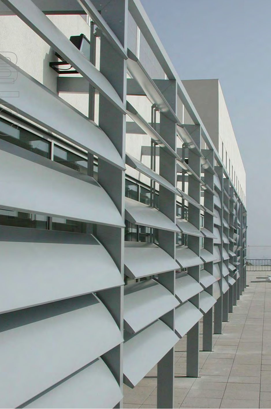
Producción y montaje de lamas orientables en la fachada del Instituto Gutmann de Barcelona.
