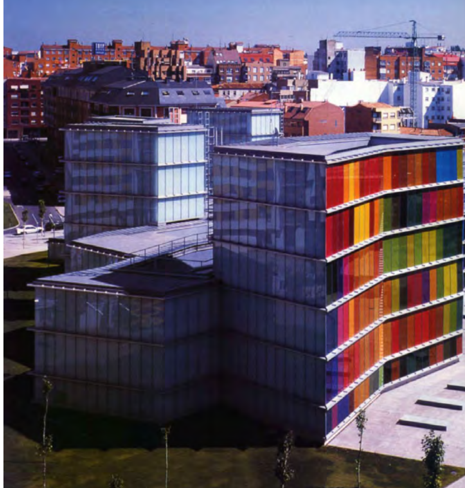
Producción y montaje de elementos de protección solar para las fachadas del MUSAC (Museo de Arte Contemporáneo de Castilla y León). León.
