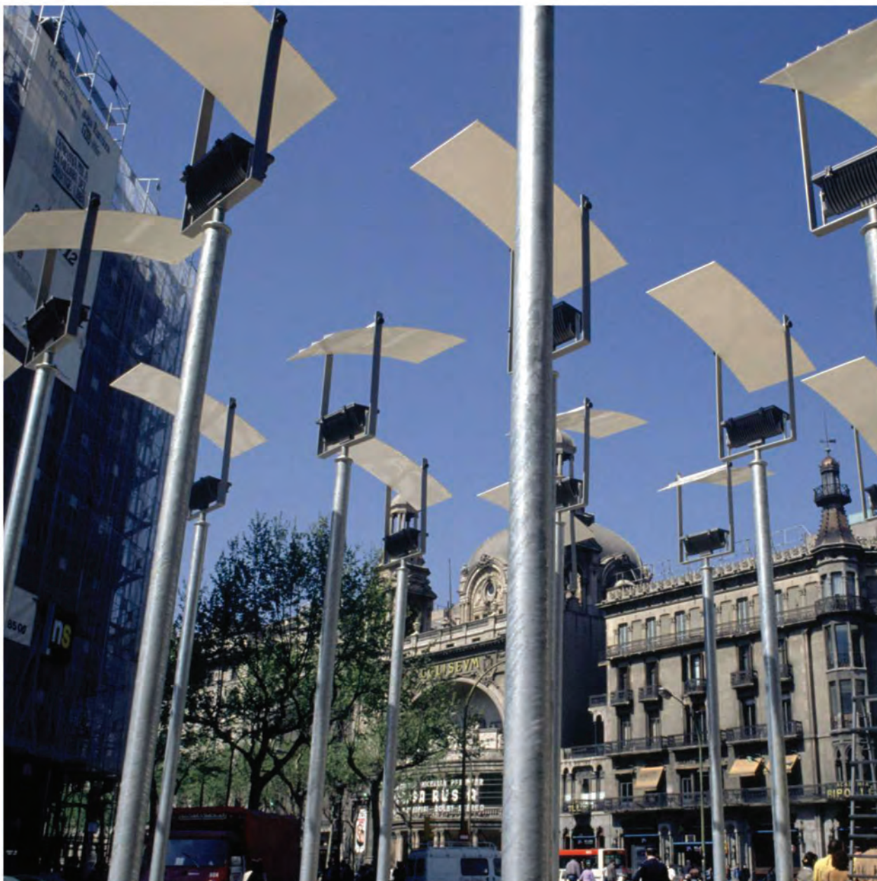
Diseño, producción y montaje de sistema de alumbrado público. Barcelona
