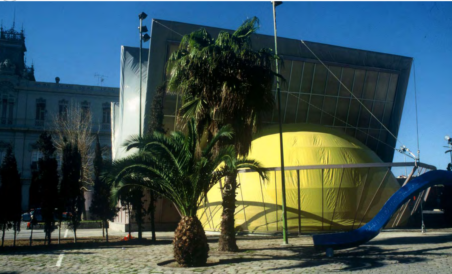
Edificio ligero, para la ubicación temporal de servicios en el Paseo Colón de Barcelona.
